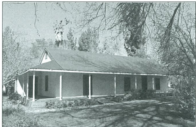
La Casa Primera - Roof Replacement
